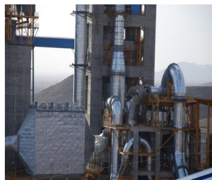
شکل ۴- تصاویری از تجهیزات پایش آلاینده ها در کارخانه سیمان زاوه: الکتروفیلتر (تصویر بالایی) و سامانه پایش آنلاین (تصویر پایینی)
