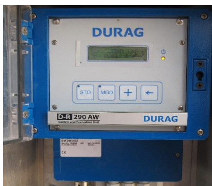
شکل ۴- تصاویری از تجهیزات پایش آلاینده ها در کارخانه سیمان زاوه: الکتروفیلتر (تصویر بالایی) و سامانه پایش آنلاین (تصویر پایینی)
