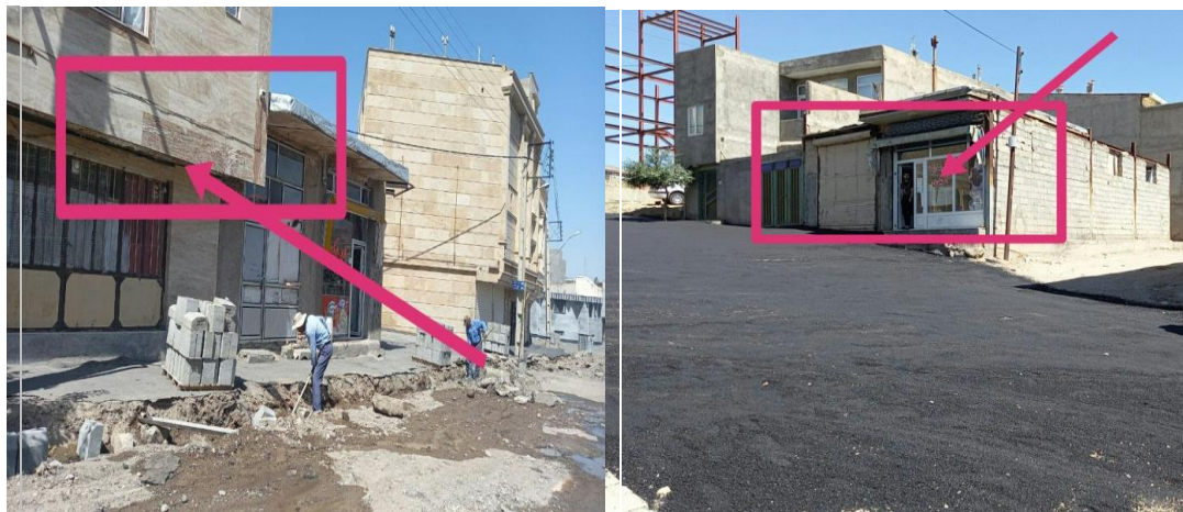
تخلف پیشروی در معبر (خارج از ضوابط ساخت و ساز)
