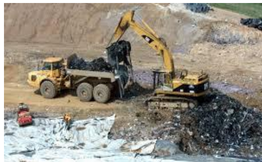
شکل ۱۱- بازکنی محل دفن جهت افزودن پسماند قدیمی به SRF
