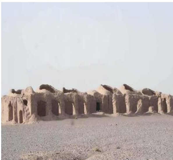
شکل ۸- تخریب دیوار شمالی و سقف توسط ضربات ماسه‌ها
