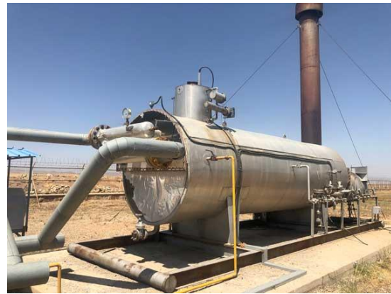
شکل ۱- نمای گرم کن های مرسوم در ایستگاه های تقلیل فشار
