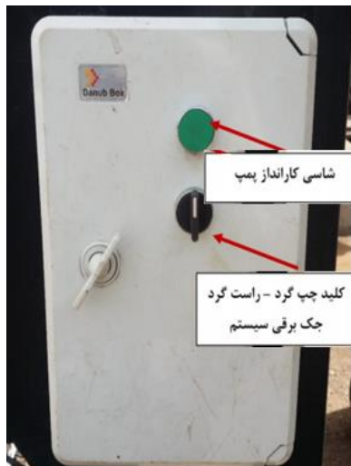
شکل ۳- کلید راه انداز پمپ و جک برقی
